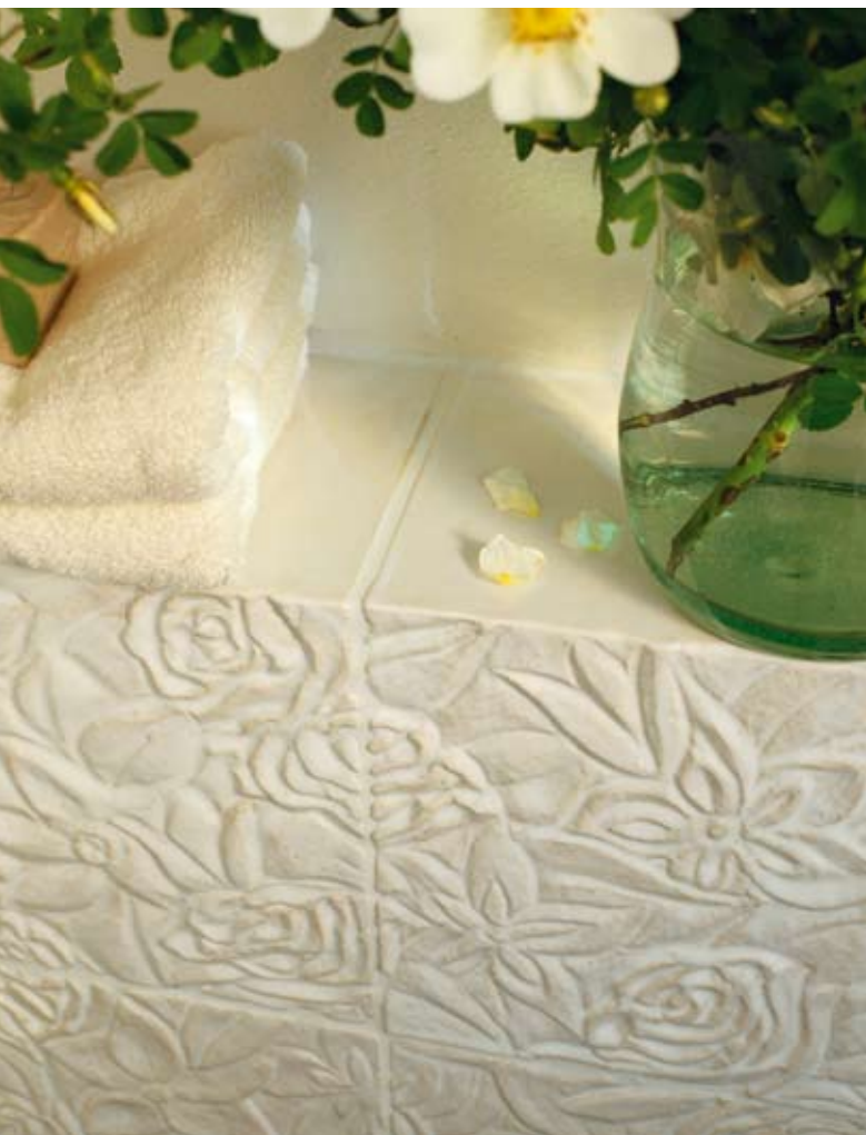
Die Fliesen hat die Baukeramikerin dünn mit einer weißen Glasur versehen. So schimmert der sogenannte Scherben leicht bräunlich durch und lässt die Fliesen optisch wärmer erscheinen.
